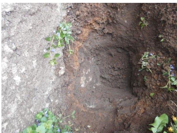
Foto č.7 – provedení sondy pro ověření spodní úrovně soklu a hloubky navázky
