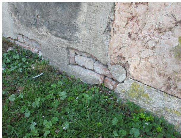
Foto č.14 – destrukce zdiva od působení vlhkosti a mrazových cyklů pod náhrobky
