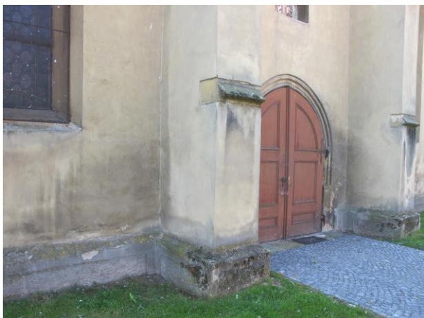
Foto č.3 – boční vstup do kostela s charakterem zpevněných přístupových ploch, vznik řas a sinic na pilíři od smáčení z pískovcových prvků
