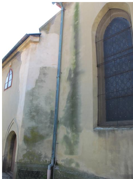
Foto č.4 – rozsáhlé biotetické napadení v ploše fasády, zaústění dešťových svodů bez lapačů splavenin
