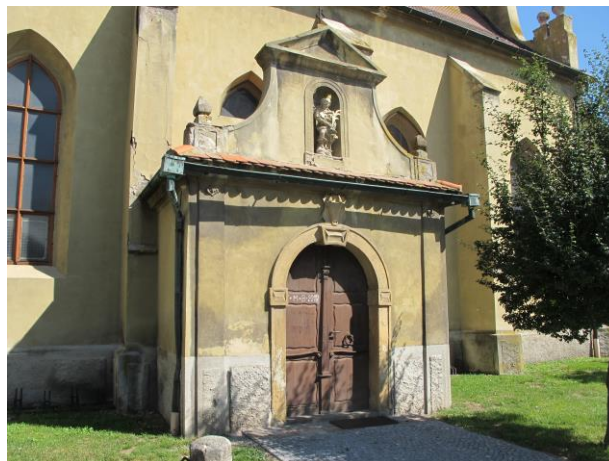
Foto č.12 – boční vstup do kostela z jižní strany, charakter přístupových ploch z drobné žulové kostky a pískovcové dlažby, poškození čelní římsy
