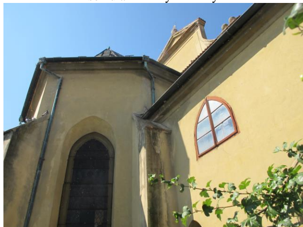
Foto č.9 – poškození fasády ve styku presbytáře a zákristie, nedokonalé provedení s omezenou údržbou u klempířských střešních prvků, biotetické napadení od střešních vod z krycích hlavic pilířů
