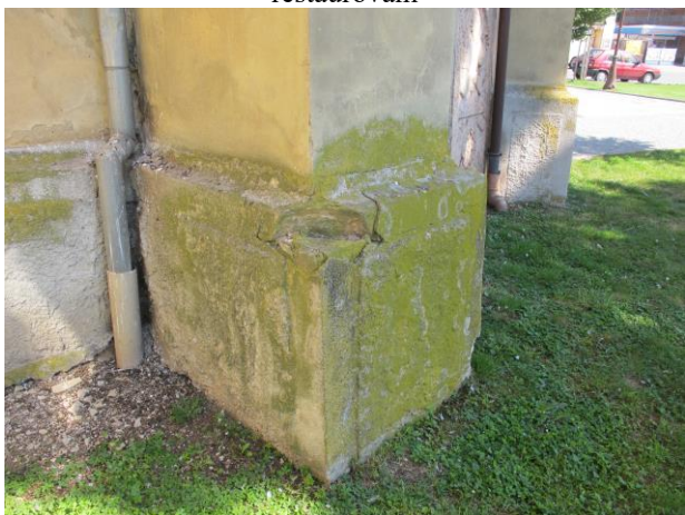
Foto č.15 – mechorosty na pilířích v soklové a nadsoklové části s poškozením pískovcových obkladů
