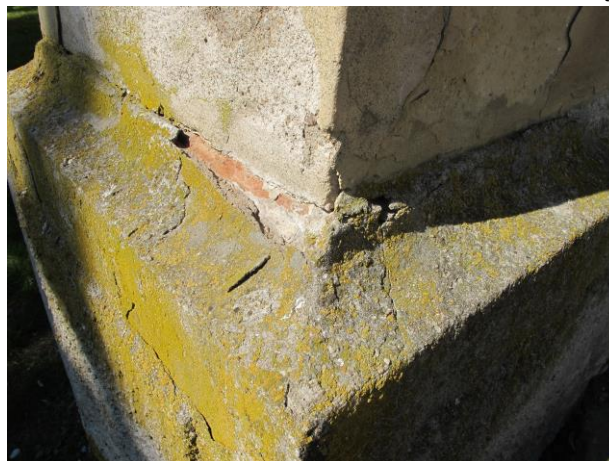
Foto č.12 – detail poškození soklu a povrchových úprav omítkami
