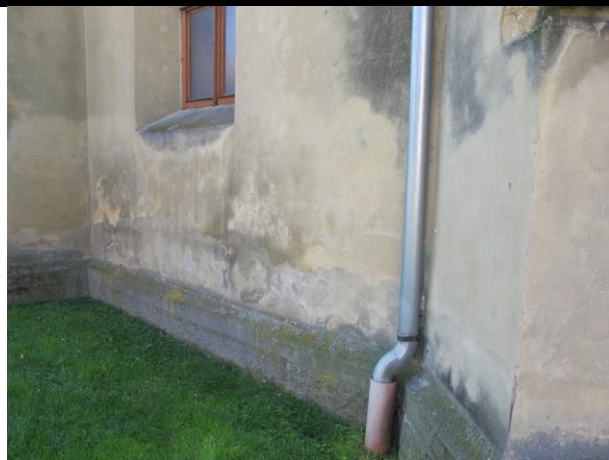
Foto č.2 – vysoká úroveň vlhkosti a vznik mikroorganismů od parapetu okna
