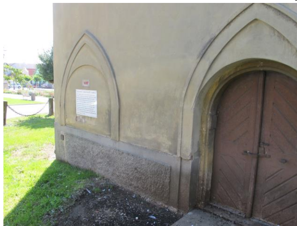
Foto č.6 – nevhodná cementová krusta soklu s omezením odvodu vodních par ze zdiva, boční vstup do zákristie a informační cedule o vývoji kostela
