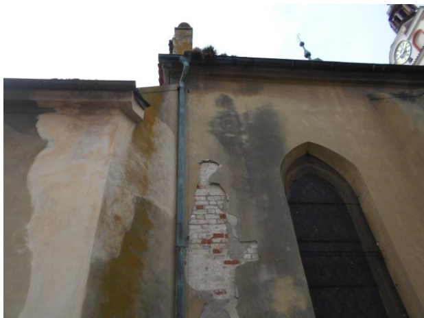
Foto č.5 – ucpání od zarůstání odtoku ze žlabu do svodu
