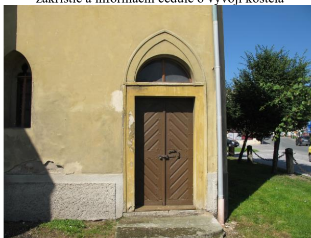
Foto č.8 – vstup do zákristie z východní strany, destrukce omítek nad soklem
