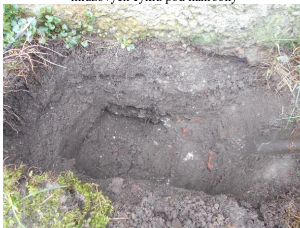
Foto č.10 – provedení sondy pro ověření spodní úrovně soklu a hloubky navážky
