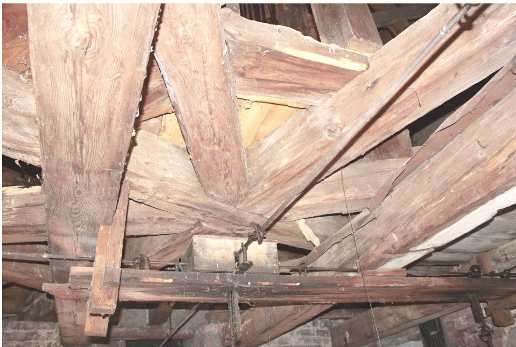
13. Celkový pohled na převodník transmisi hodinový ručiček umístěný pod střední částí krovu věže.
