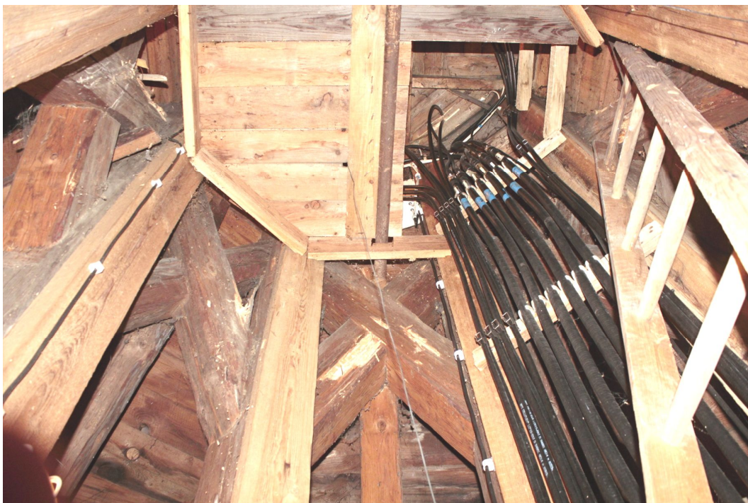
17. Žebřík do lucerny věže a kabelové trasy k telekomunikačním anténám umístěným v lucerně věže.
