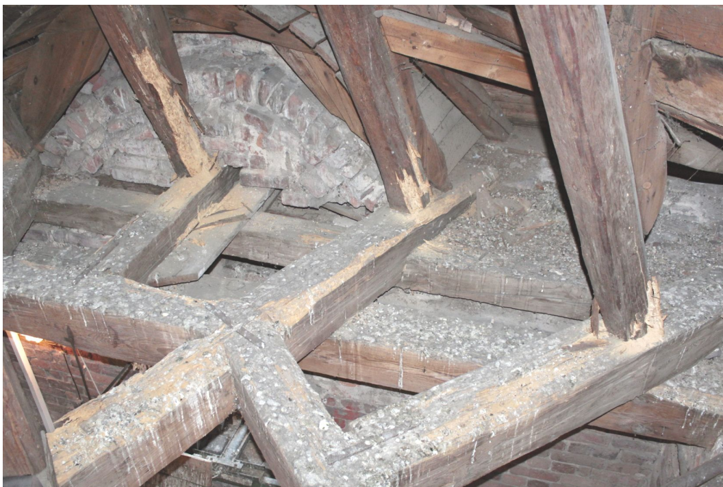
9. Pohled na kalamitní napadení krokví a prvků nosného trámového roštu tesaříkem.
