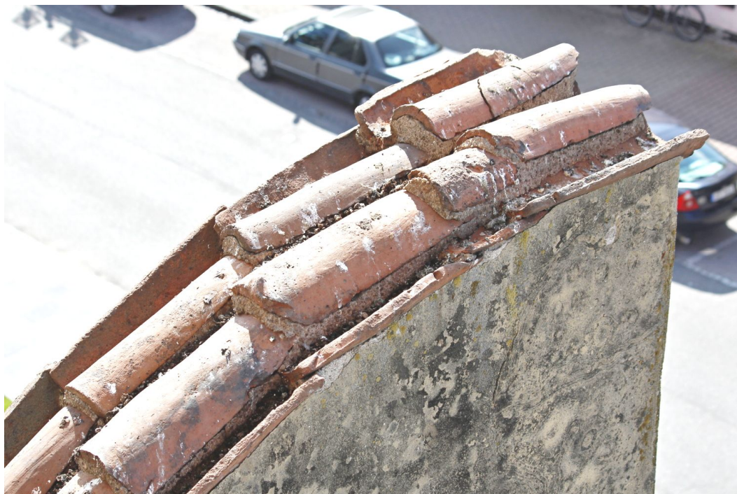
33. Stávající krytí koruny západní štítové zdi lodi keramickými prejzy kladenými do malty.
