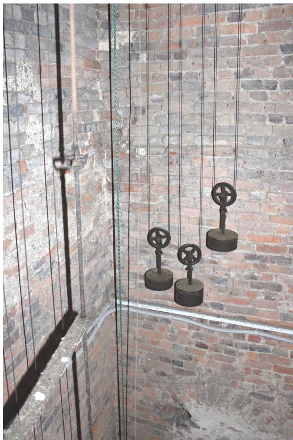
29. Závaží od mechanického hodinového stroje, který bude nahrazen strojem elektronickým.
