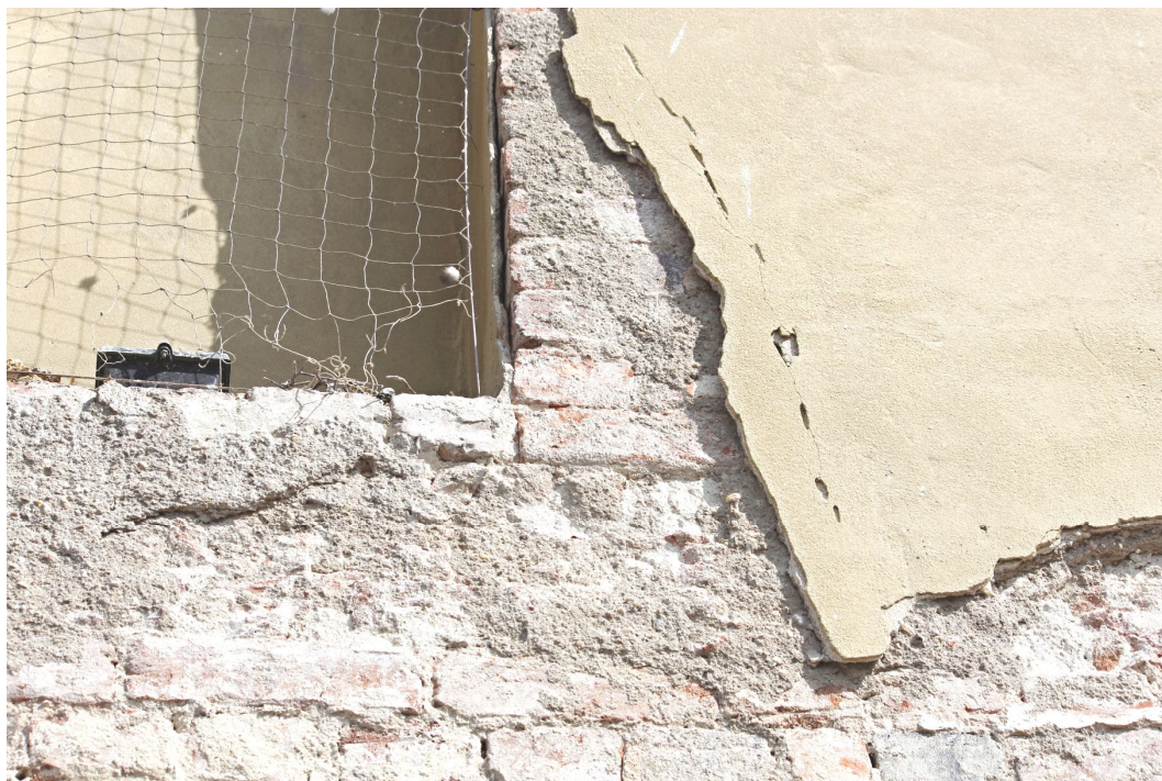
35. Detailní pohled na odsekanou římsu pod parapetem oken u spodního zvonového patra.
