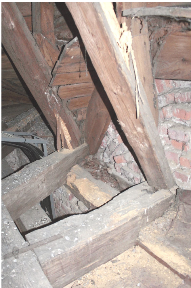
7. Pohled na prvky ve spodní části krovu věže destruované tesaříkem.
