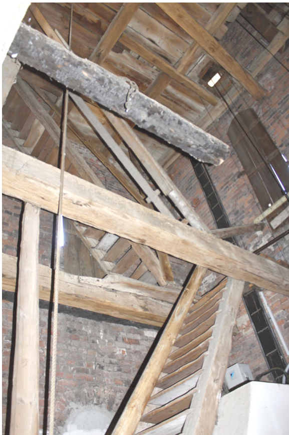
28. Celkový pohled na schodiště v místnosti s hodinovým strojem (3. a 4. NP) jako jediný výstup do horních pater věže kostela. Nahoře na snímku torzo ohořelého stropního trámu.
