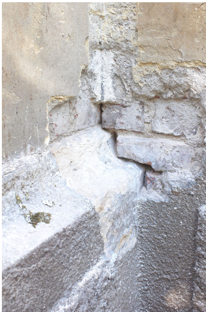
41. Oblounová římsa na západní štítové zdi prostupuje obvodovou zdí věže – doklad toho, že horní část věže byla k lodi kostela přizděna dodatečně.
