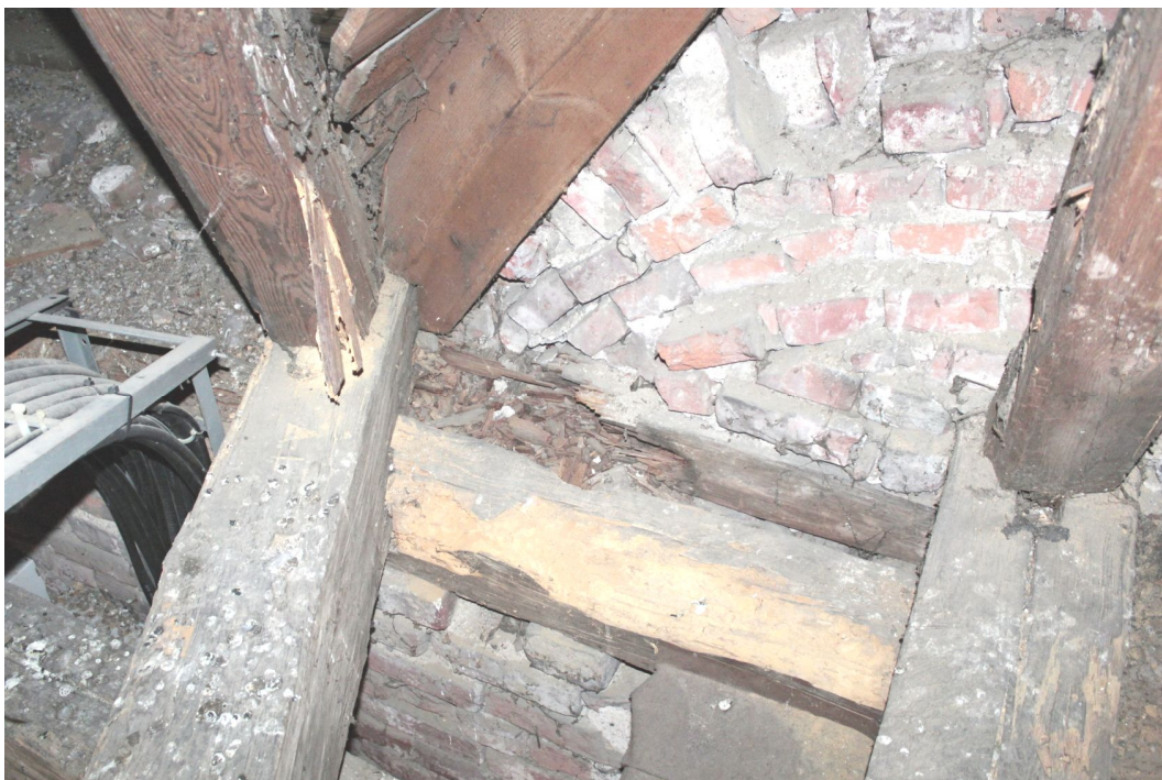
7. Pohled na prvky ve spodní části krovu věže destruované tesaříkem.
