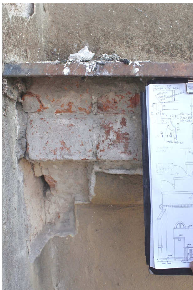
39. Detailní pohled na profilaci kordonové římsy s odsekanou horní cihlou.
