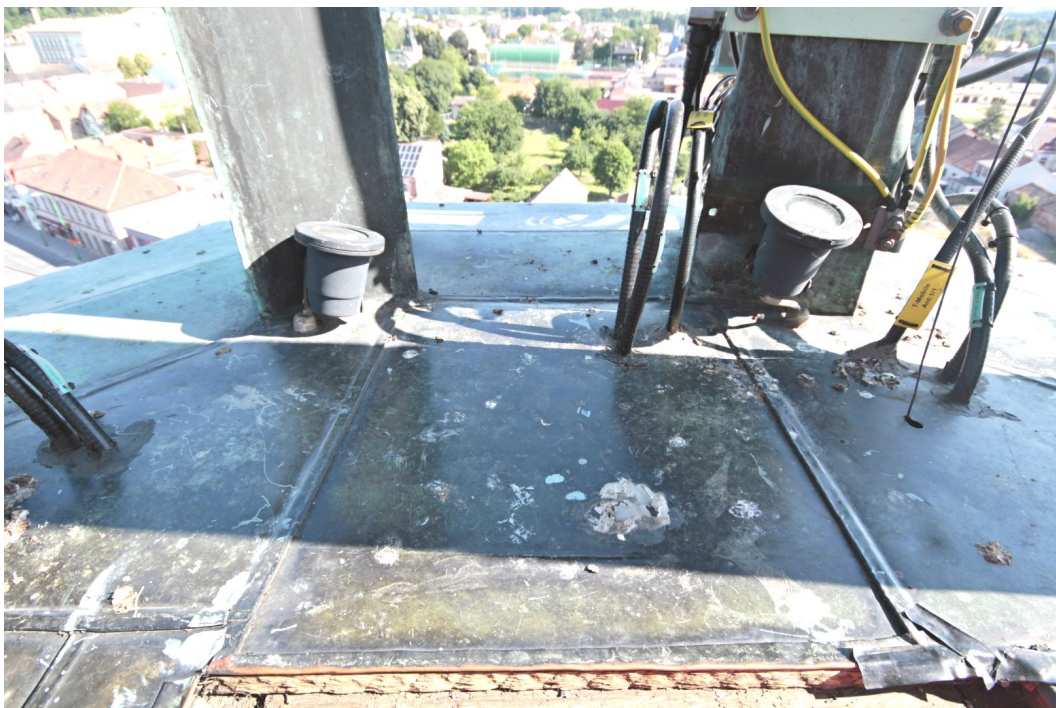
20. Podlaha lucerny věže krytá plechem s částí poklopu, se slavnostním osvětlením a částí kotvení panelových GSM antén telekomunikační společnosti O2 CR.
