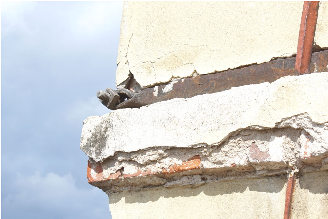
37. Detailní pohled na novodobou plochou římsu zakrývající stahující obruč z pásové oceli a původní závlač zedních kleští v úrovni zvonového patra věže.
