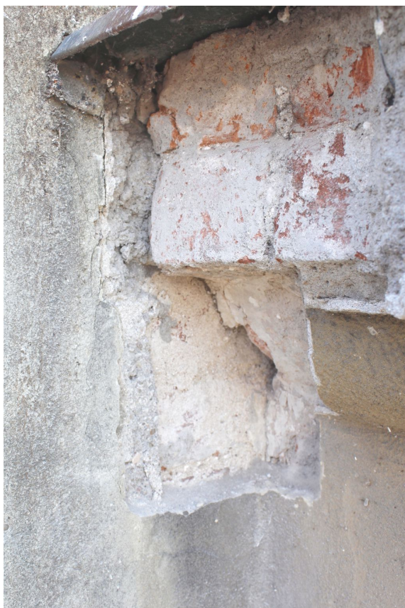
39. Detailní pohled na profilaci kordonové římsy s odsekanou horní cihlou.
