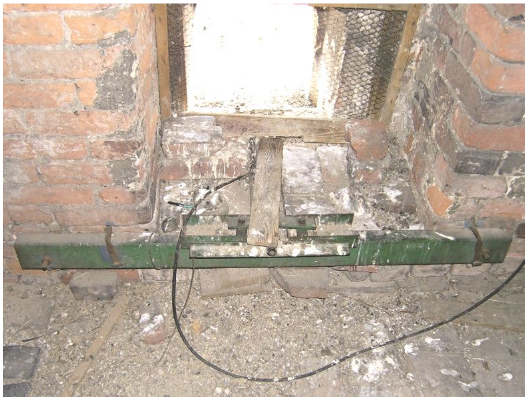
15. Detailní pohled na kotvení slavnostního osvětlení hodinových ciferníků z ocelových tyčí a profilů.
