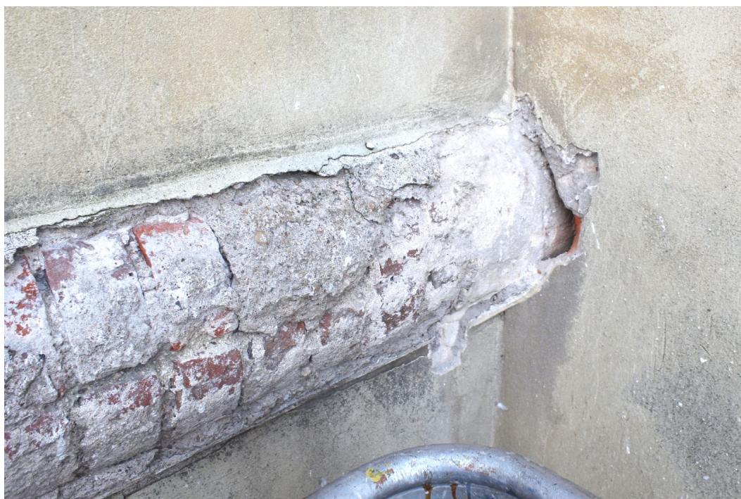
41. Oblounová římsa na západní štítové zdi prostupuje obvodovou zdí věže – doklad toho, že horní část věže byla k lodi kostela přizděna dodatečně.
