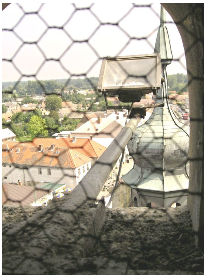
15. Detailní pohled na kotvení slavnostního osvětlení hodinových ciferníků z ocelových tyčí a profilů.
