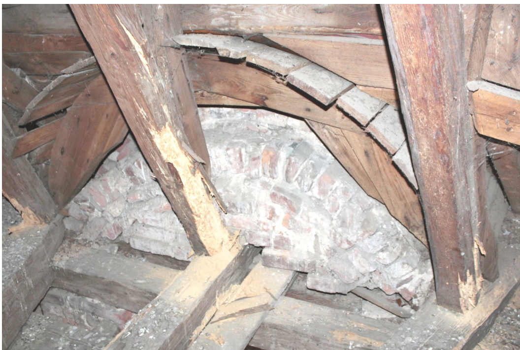
10. Detailní pohled na destrukci dřevní hmoty spodní části krokve napadené tesaříkem.
