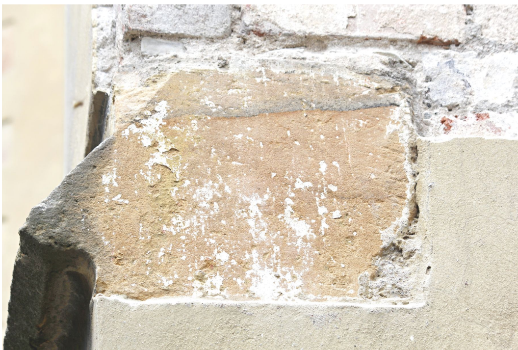
38. Detailní pohled na profilaci kamenné římsy ve spodní části věže.
