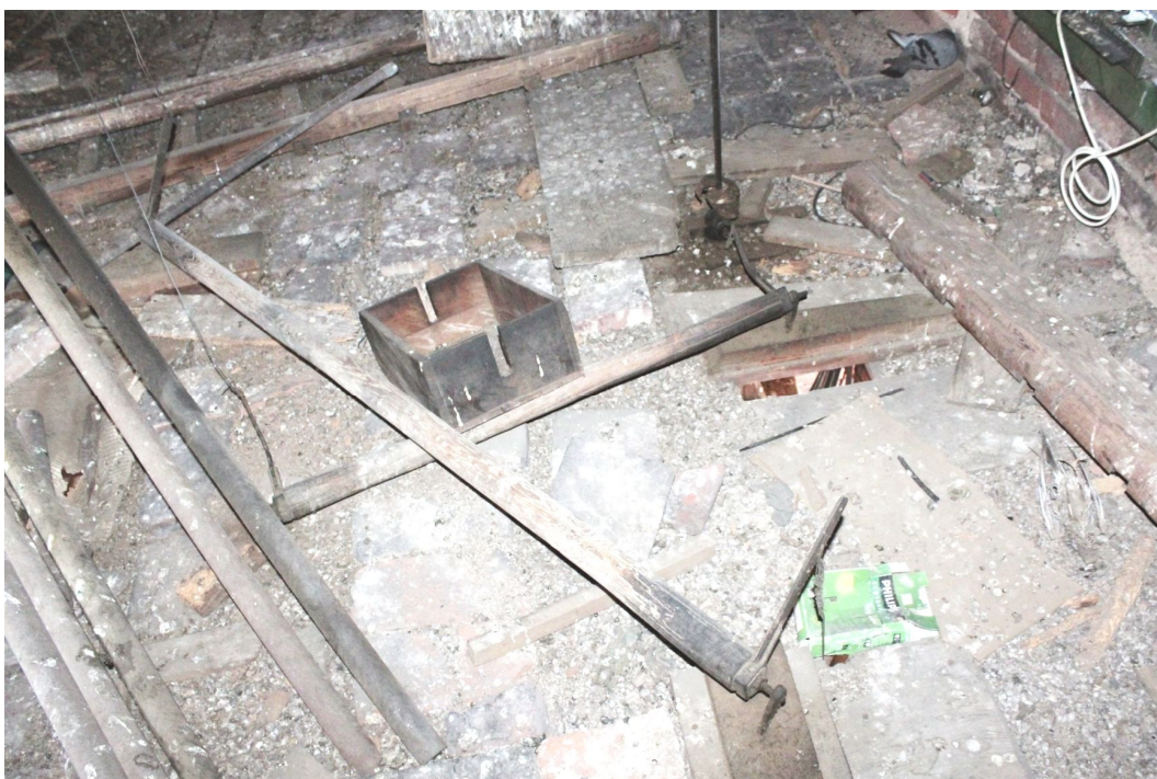
14. Celkový pohled na mechanický systém odbíjení cimbálů z dřevěných otočných hřídelí umístěný na podlaží půdy pod krovem věže.
