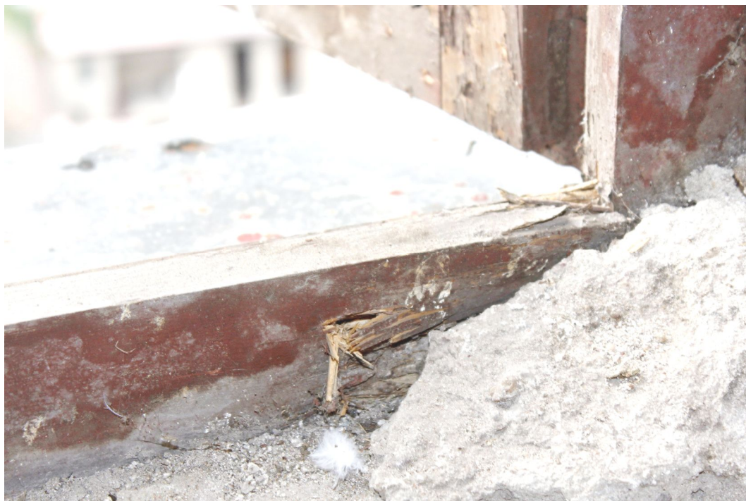
31. Poškození rámu žaluziové okenice hnilobou v horním zvonovém patře věže kostela.
