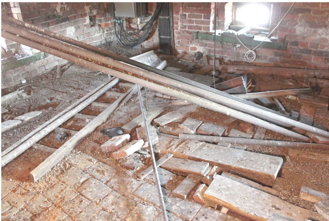
11. Pohled na podlahu půdy pod krovem věže dlážděnou keramickými půdovkami (topinkami).
