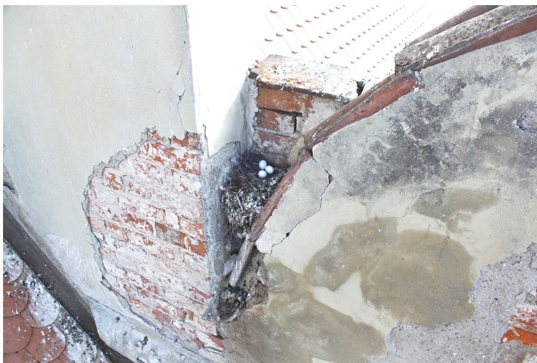
34. Pohled na provedení zdiva u úžlabí vlaštovčího ocasu na koruně západní štítové zdi lodi kostela.
