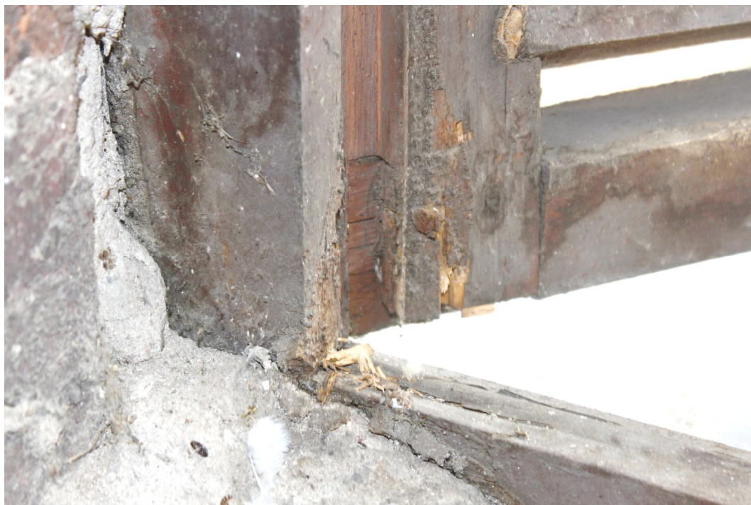
32. Poškození rámu žaluziové okenice hnilobou v horním zvonovém patře věže kostela.
