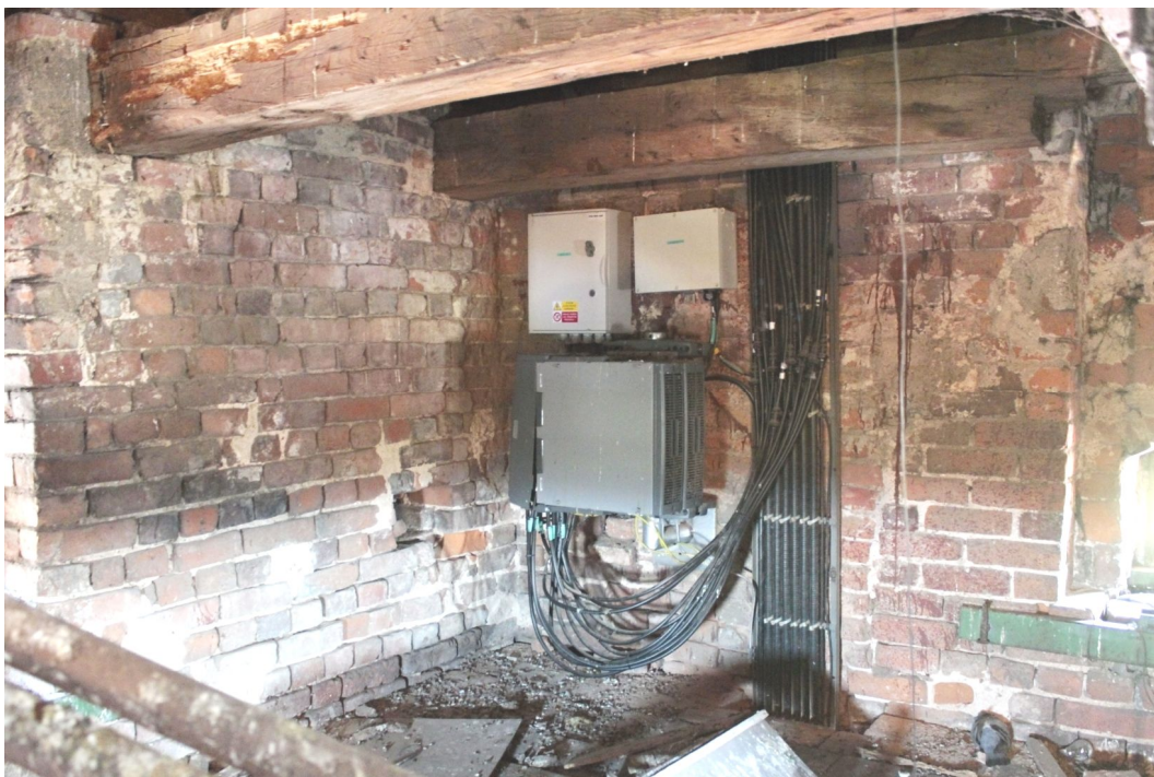
21. Pohled na zavěšené technologické moduly zařízení pro přenos dat telekomunikační společnosti v místnosti na půdě pod krovem věže.
