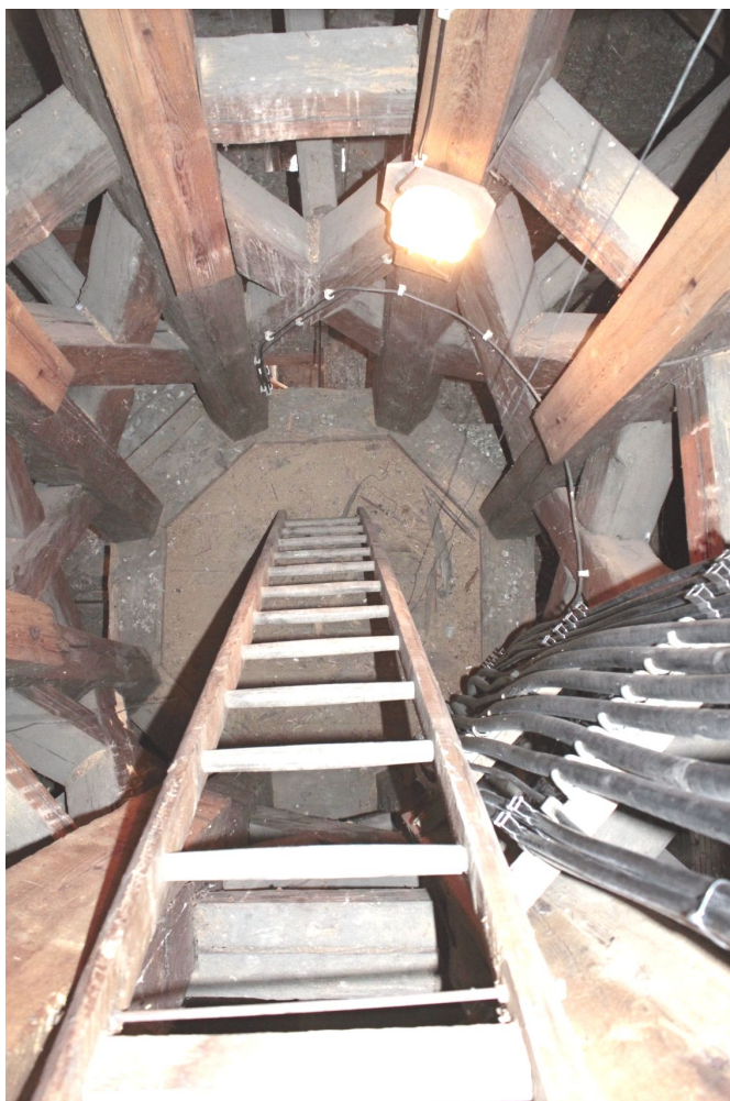
17. Žebřík do lucerny věže a kabelové trasy k telekomunikačním anténám umístěným v lucerně věže.
