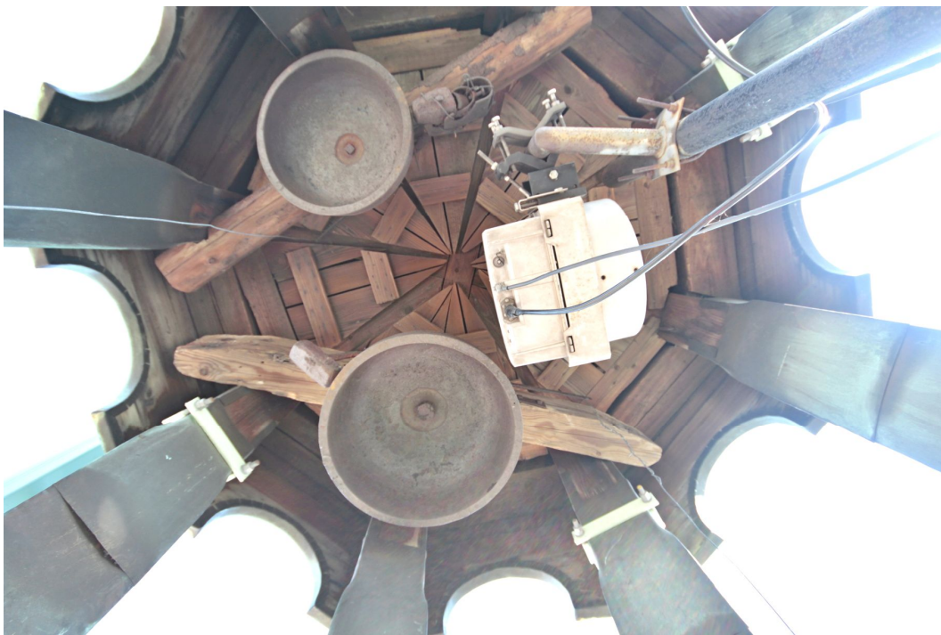
19. Pohled vzhůru v lucerně věže na zavěšené cimbály a parabolickou MW anténu telekomunikační společnosti O2 CR.
