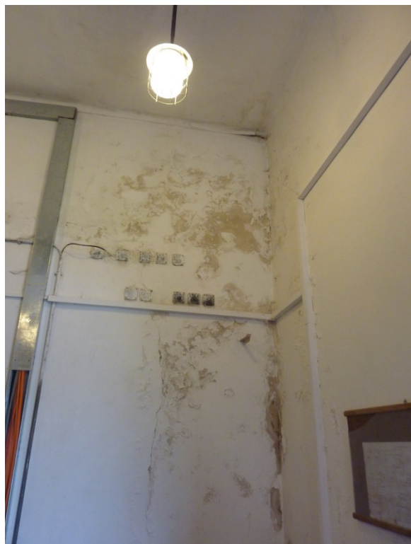
poruchy v interiéru strojovny (z důvodu zatékání)
