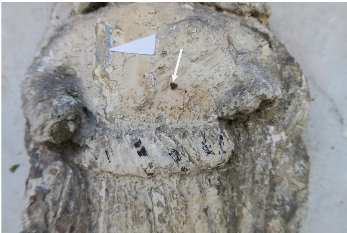
Šipky ukazují hranici nově doplněné omítkové vrstvy
