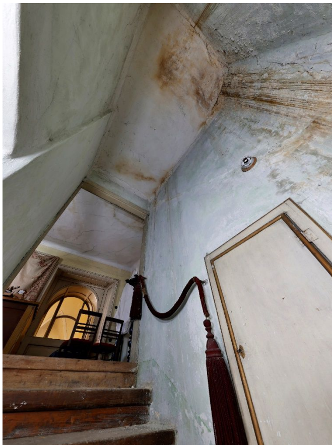
18. Horní část schodiště do „panské“ oratoře v patře SV přístavku s poškozenou omítkou na stěnách a podhledu, vpravo vstup do komínového prostoru (březen 2022).
