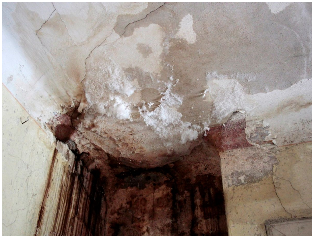
28. Detailní pohled na významné poškození omítky s výskytem plísní na podhledu a stěnách od zatékání do bývalého komína v severozápadním rohu „panské“ oratoře (červen 2018).
