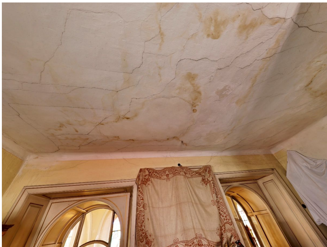
24. Detailní pohled na poškození omítky na podhledu v jižní části „panské“ oratoře (březen 2022).
