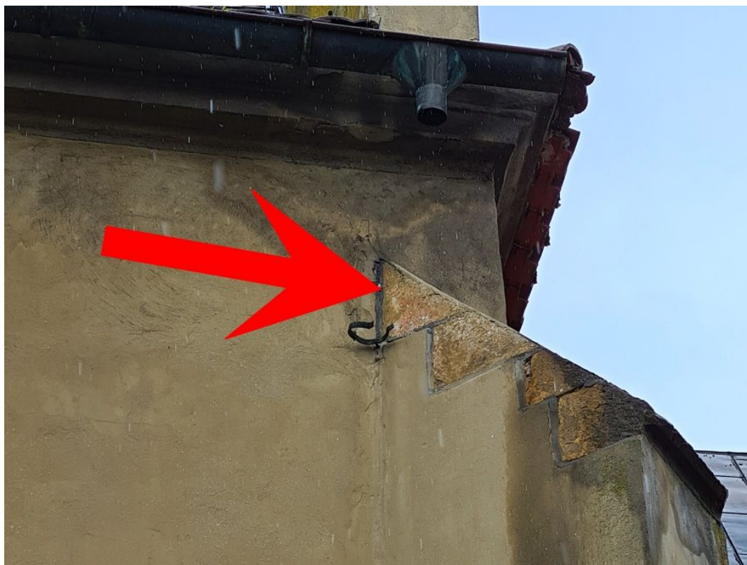
32. Zbytky původní barevnosti – páleného okru – na kamenném kvádru na horní straně JV nárožního opěrného pilíře (květen 2022).
