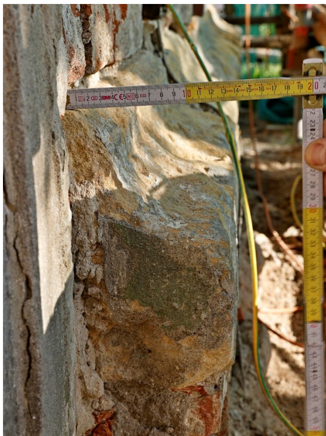
13. Pohled na profilaci soklu po otlučení omítky na západním průčelí kostela (duben 2022).
