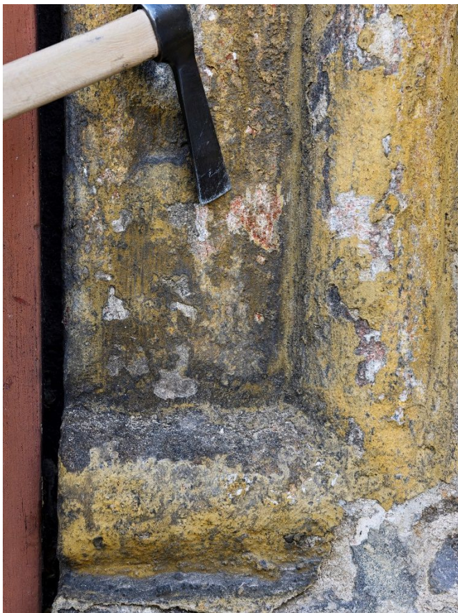
11. Detailní pohled na původní nátěr v odstínu páleného okru na severním portálu vstupu do lodi (duben 2022).
