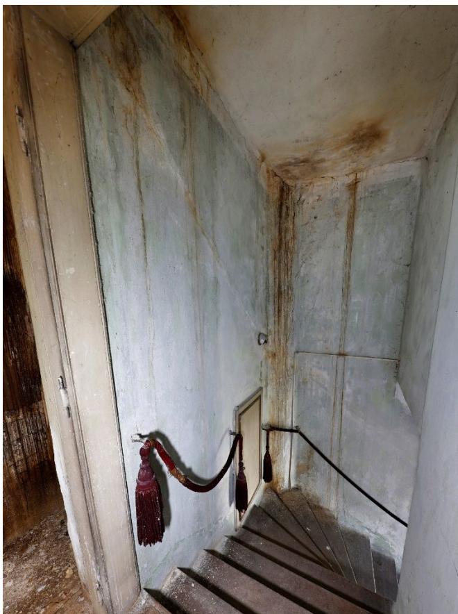
19. Horní část schodiště do „panské“ oratoře v patře SV přístavku s poškozenou omítkou na stěnách.
