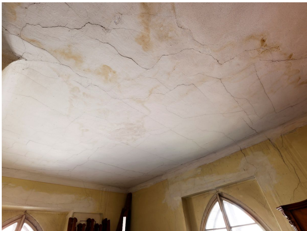
22. Detailní pohled na poškození omítky na podhledu v severovýchodní části „panské“ oratoře (březen 2022).
