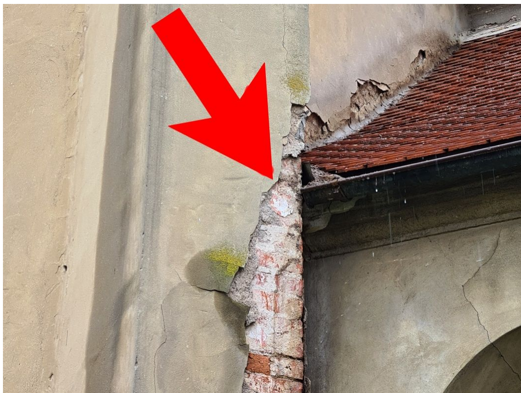
31. Zbytky původní barevnosti – páleného okru – na omítce na čelní stěně JV nárožního opěrného pilíře (květen 2022).
