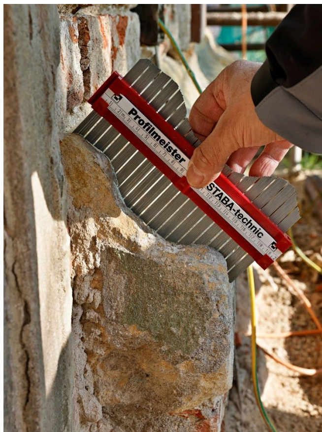
14. Pohled na profilaci soklu po otlučení omítky na západním průčelí kostela (duben 2022).
