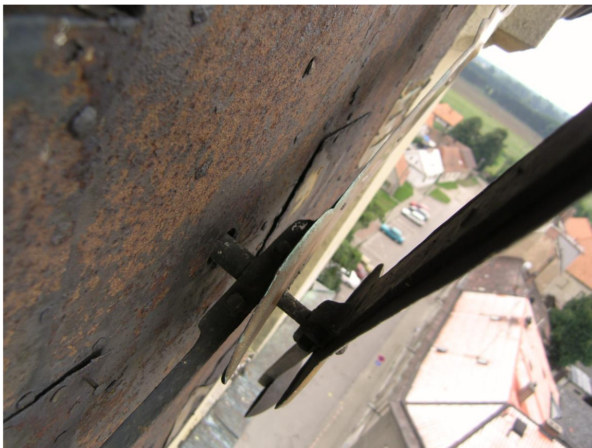
Obr.č. 5 detail havarijního stavu ciferníku. Snímek ukazuje hloubkovou korozi kovu. Plechové pláty jsou úbytkem základního materiálu místy bez kovového jádra , některé části zcela chybí
