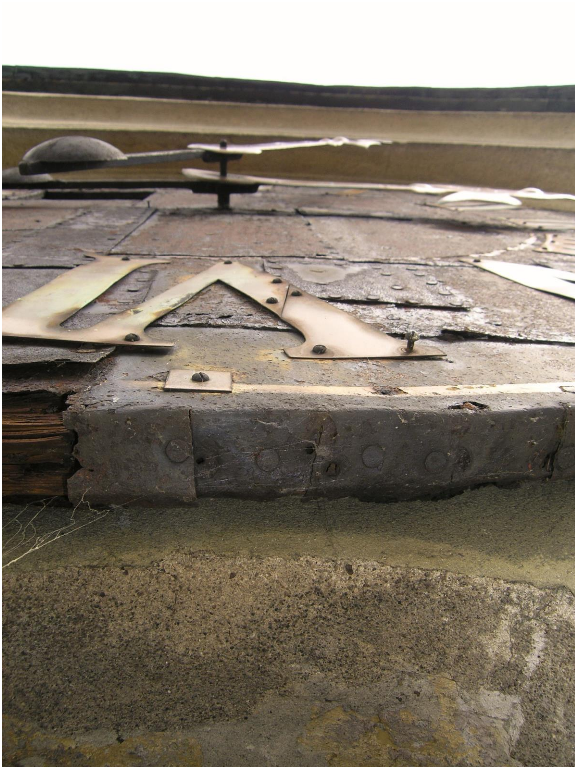
Obr.č. 4 Detailní pohled na spodní část ciferníku. Ze snímku je patrný rozsah poškození způsobený korozním procesem. Plechové pláty jsou úbytkem základního materiálu místy bez kovového jádra , některé části zcela chybí. Dřevní hmota je vlivem zatékání silně narušená.
